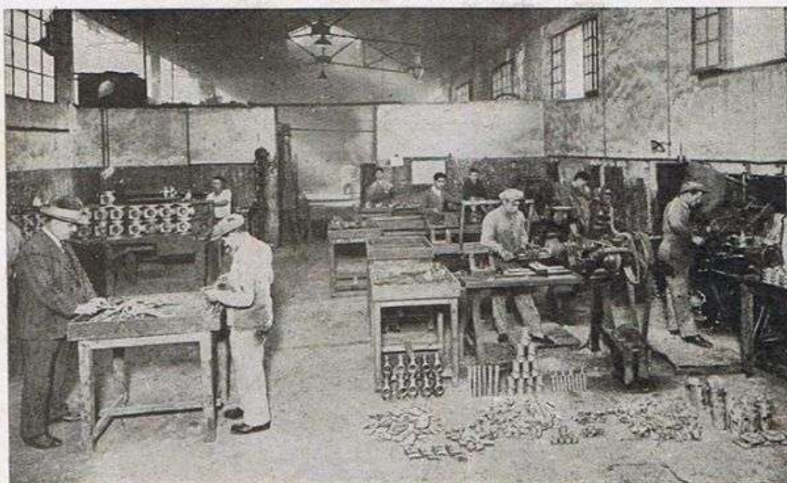
Atelier d'usinage de robinetterie
